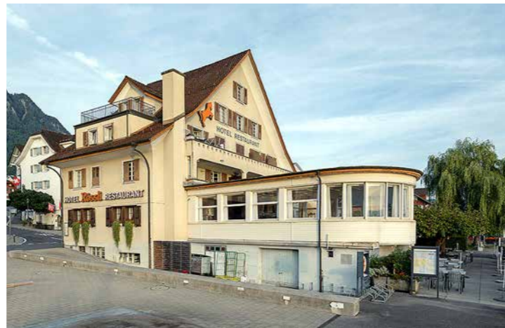
Hotel Rössli, im Kern ein Blockbau aus dem frühen 19. Jahrhundert
