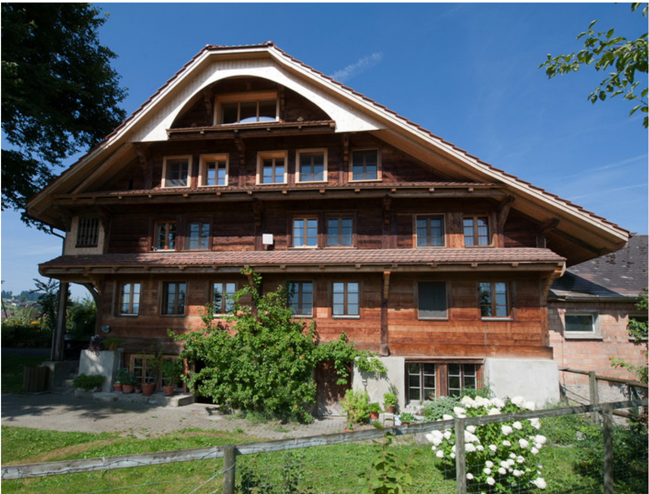
Einbau von einer Wohnung in das Dachgeschoss des Wohnhauses
