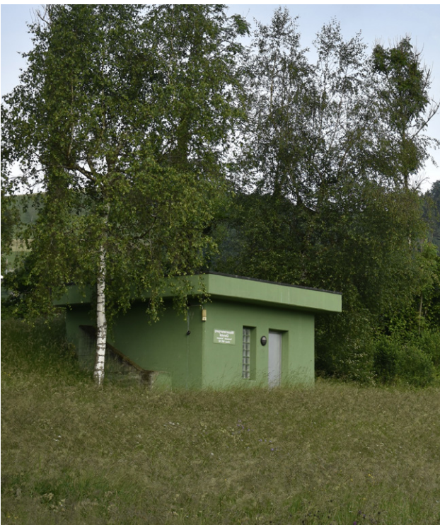
Grundwasserpumpwerk farblich angepasst
