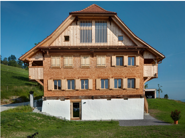
Ausbau des Dachgeschosses
