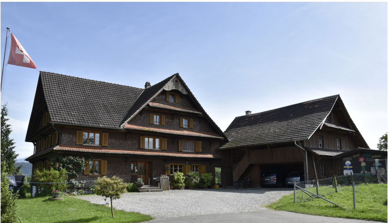
Garage in den Nebenbau integriert
